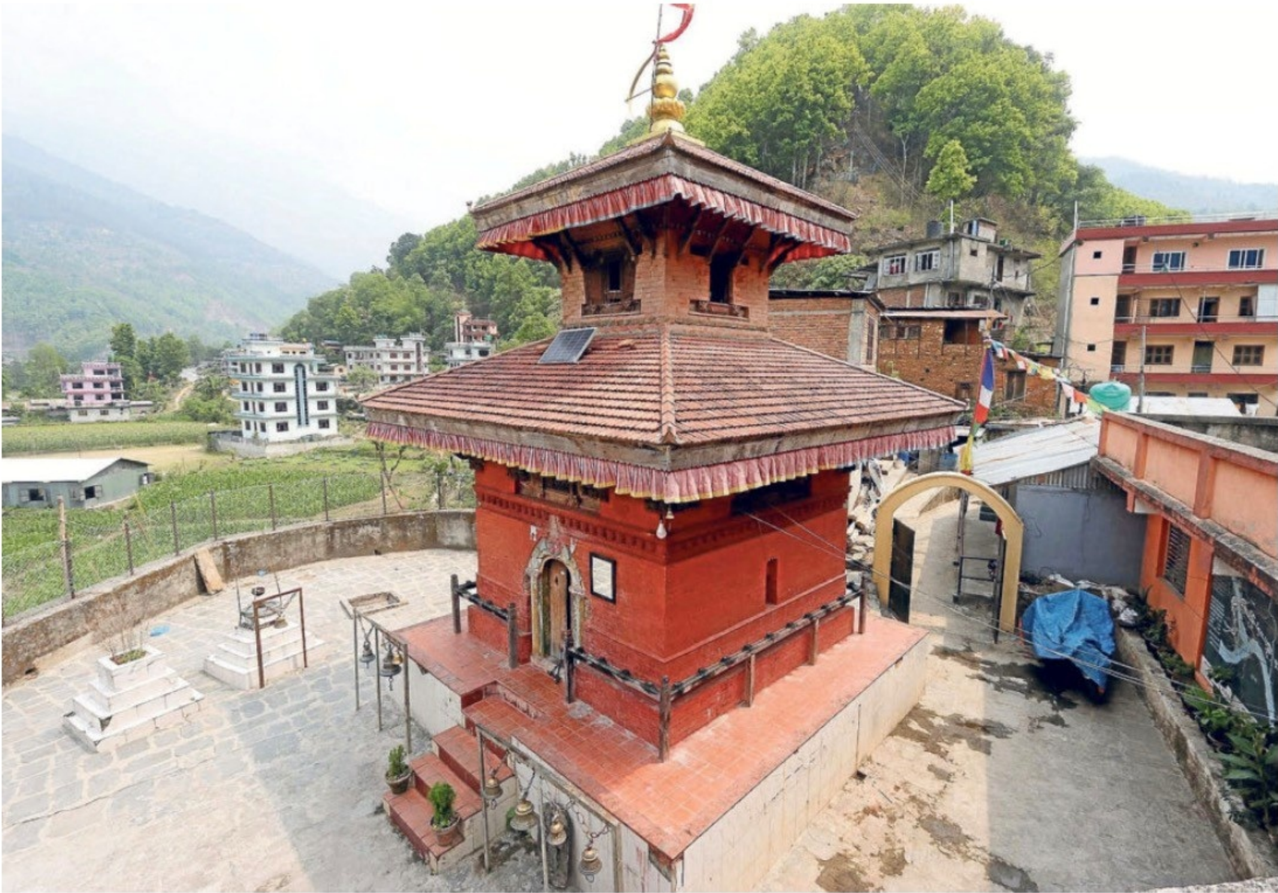
Ein Bild aus besseren Zeiten: Der Rama geweihte zweistöckige Tempel in Betrawati wurde von den Fluten vollständig fortgespült. Er war schon beim Erdbeben 2015 schwer beschädigt und wieder aufgebaut worden. Foto: NHDP
